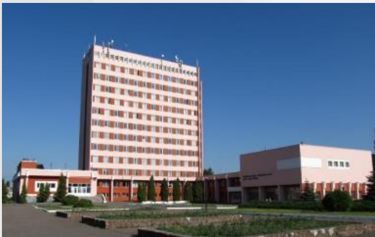
Здание учебного корпуса г. Гомель, ул. Барыкина, 269
