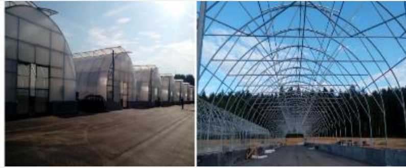
Добрушский район, аг. Корма (производство теплиц)
