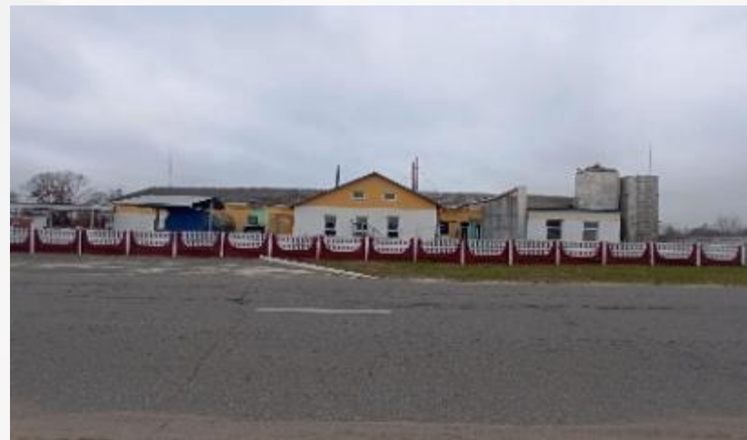
Комплекс зданий производственного участка г. Ельск, ул. Советская, 59
