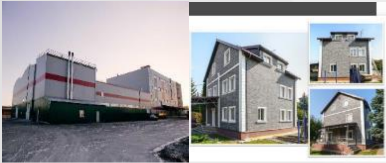
г. Гомель, ул. Достоевского, 1 производство декоративных панелей
